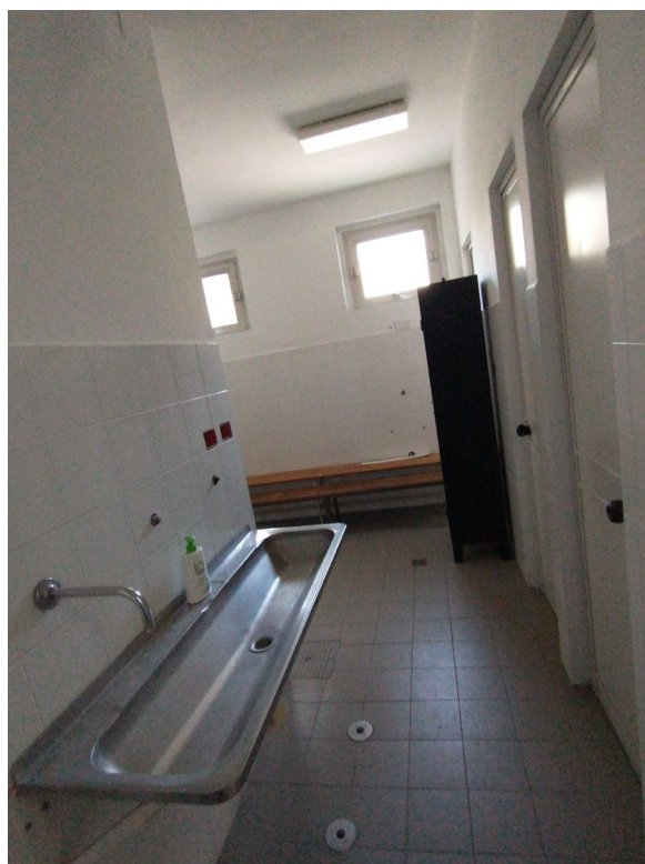
Foto 16: Fabbricato palestra – interno zona nuovi spogliatoi
