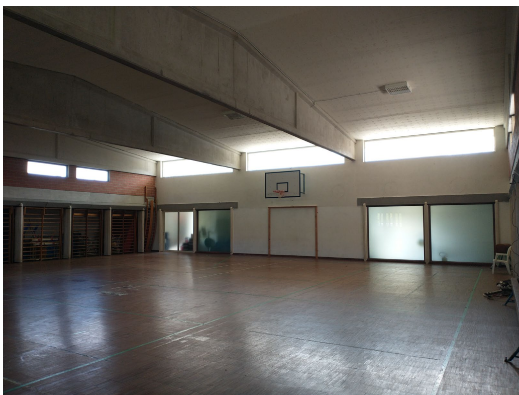
Foto 14: Fabbricato palestra - interno
