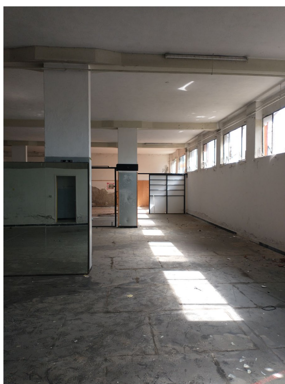
Foto 05: Fabbricato ex giudice di pace – interno piano terra (ex palestra)
