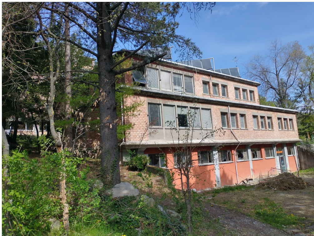
Foto 02: Fabbricato ex giudice di pace - prospetto sud
