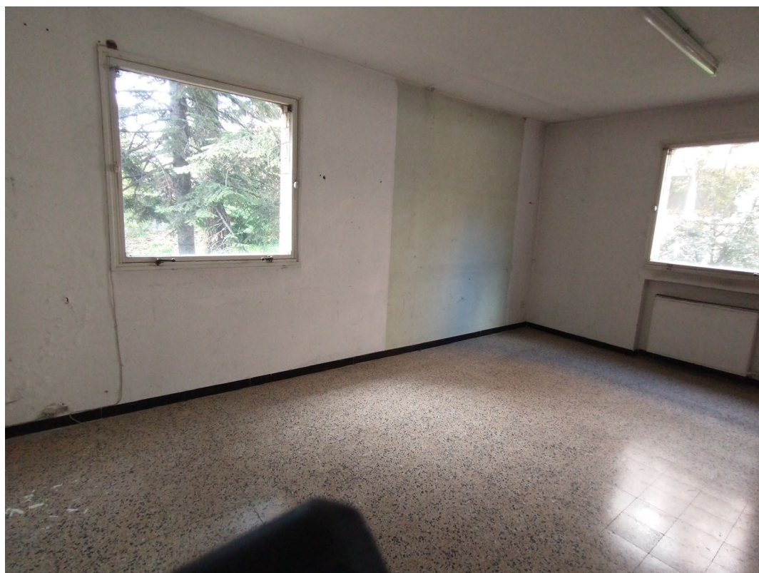
Foto 08: Fabbricato ex giudice di pace – interno piano secondo
