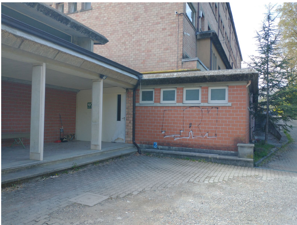
Foto 15: Fabbricato palestra – zona nuovi spogliatoi
