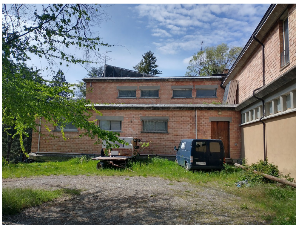
Foto 03: Fabbricato ex giudice di pace - prospetto est
